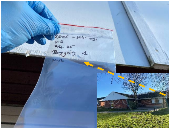
#27 Prøve M3 er udtaget fra gavlbeklædning på Bygning 1.
