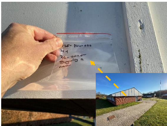
#21 Prøve M1 er udtaget fra gavlbeklædning på Bygning 2.
